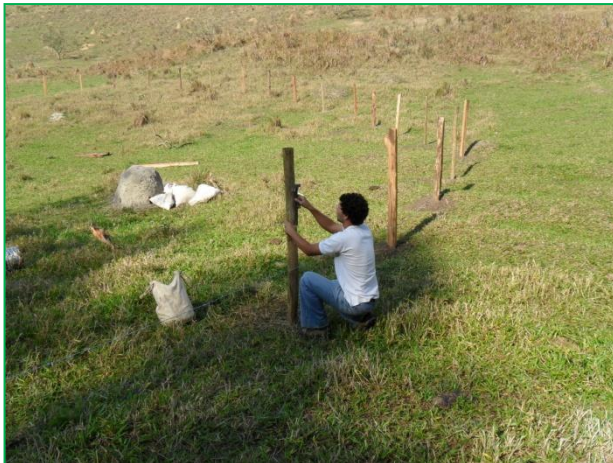
Medição da altura dos arames no moirão
